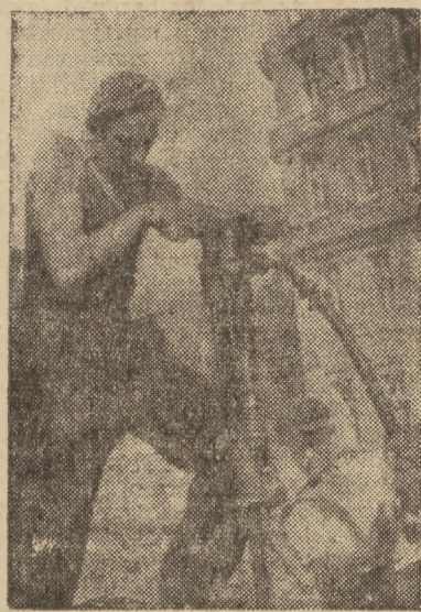
Pracy przy odbudowie
