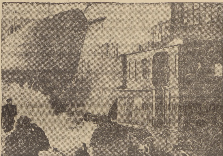
Gdańsk, Stocznia Nr 1, buduje kutry rybackie konstrukcji metalowej. Towarzystwo Połowów Dalekomorskich zamówiło 10 takich kutrów. Kuter stalowy posiada 17,4 m długości, 5 m szerokości i pojemność 15 ton paliwa oraz 15 ton ryb, co umożliwia jednostce przebycie 1.500 mil morskich. Kutry są całkowicie wykonane przez Stocznia Polską według planów Polaka konstruktora inż. Doczera. Na zdjęciu kuter rybacki w stoczni
