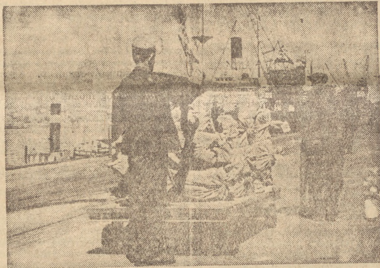
Gdynia. Robotnicy wyładują pocąg zamrażający ze statków
