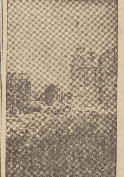
Długie trasy często utrudniają do my stojące w miejscach przeznaczonych na ulicę. Domy te muszą ulec zburzeniu. Jednakże mieszkańcy ich nie zostają bez dachu nad głową...
