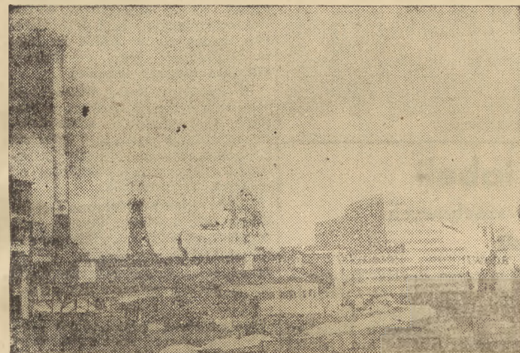
Kopalnia „Zabrze-Wschód“ Widok ogólny.
