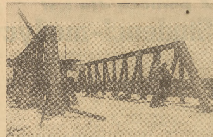
Budowa mostu Zawodny, który połączy Gdańsk z Olszynką.
