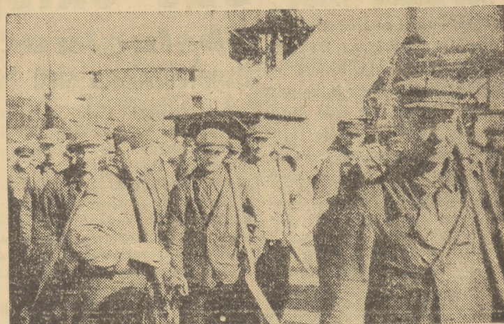
Pomimo daleko idącej mechanizacji załadunku węgla dotychczas żadne urządzenie techniczne nie zdola zastąpić pracy trymera, który w łukach statku równomiernie rozdziela wrzucany przez kran czy taśmowce węgiel.
