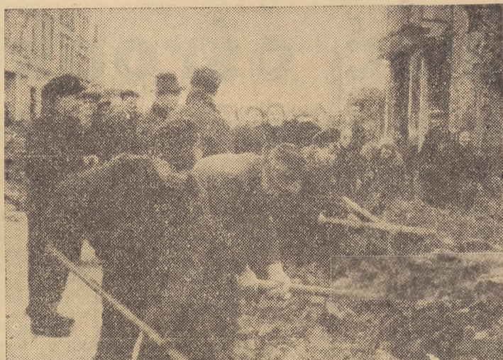
Do najbardziej zniszczonych miast naszego województwa należy Elbląg. Nie zrażają się tym jednak mieszkańcy i w miarę swoich możliwości, przyczyniają się do odbudowy miasta. Na zdjęciu grupa pracowników Zakładów Budowy Maszyn i Turbin przy odgruzowywaniu jednej z ulic elbląskich.
