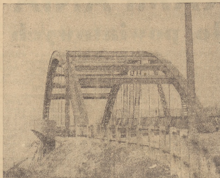
W porcie gdańskim zbliża się ku końcowi odbudowa wiaduktów, zniszczonych w czasie działań wojennych. Jednym z ostatnio odbudowanych jest wiadukt nad torami kolejowymi, przebiegającym przez ulicę Chrzanowskiego. Obecnie układana jest nawierzchnia jezdnia. Nowo odbudowany wiadukt zostanie w najbliższym czasie oddany do użytku i przyczyni się do znacznego usprawnienia komunikacji między miastem, a portem.
