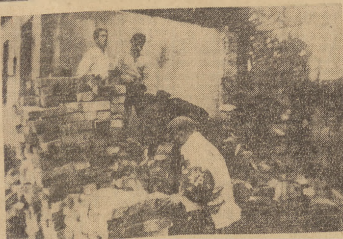
ORMO-wcy przy budowie „Domu Kultury” w Gdańsku-Olszynie
