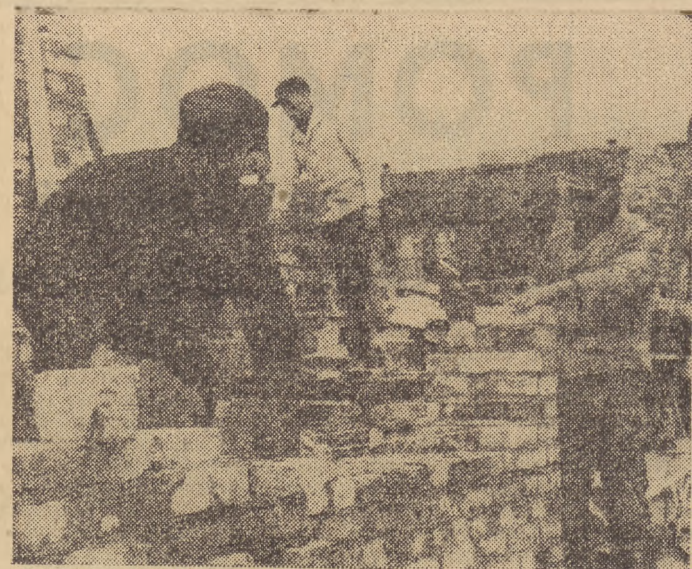
Przy ul. Korzennej w Gdańsku powstaje nowy dom mieszkalny przeznaczony dla pracowników Banku Gospodarstwa Krajowego
