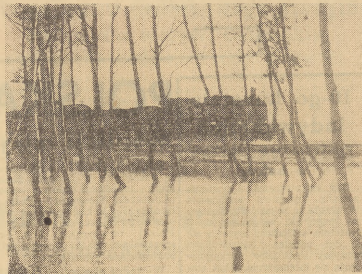
Podczas wielodniowych sztormów w ciągu bieżącej zimy wzburzone fale morskie wielokrotnie zagrażały komunikacji kolejowej na Helu. Woda podchodziła często pod same tory kolejowe, stwarzając niebezpieczeństwo ich podmycia. Dzięki jednak ofiarnej pracy kolejarzy, łączność kolejowa z Hellem została utrzymana.
