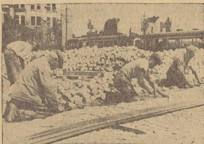
Odcinek ulicy Marszałkowskiej od trasy W—Z w stronę śródmieścia jest obecnie poszerzany. Na zdj.: Brukarze przy pracy
