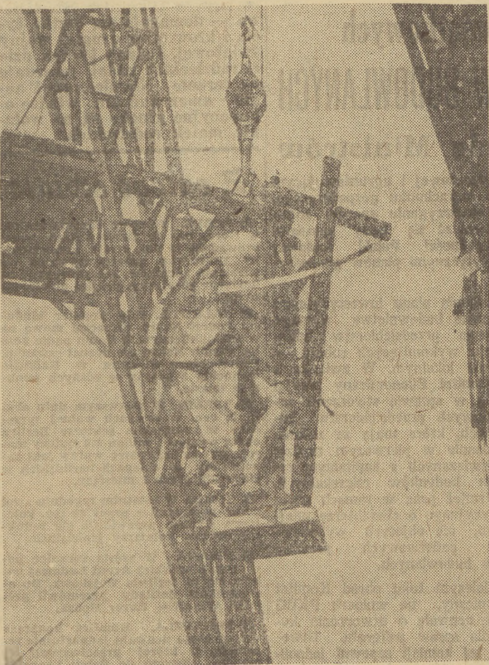
Kolumna Zygmunta III-go, stanęła na cokole. Dnia 12 bm. o godz. 20 m. 9 rozpoczęło ustawianie statuy na cokole. Na zdjęciu — podciąganie 5-tonowej statuy
