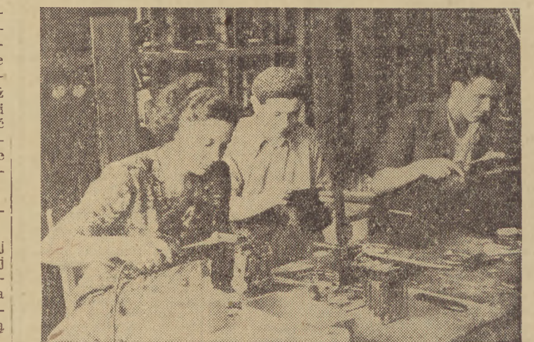
Grupa montażowa, odbudowująca centralę automatyczną gdańskiej sieci telefonicznej. Od lewej: ob. Małgorzata Tietz, Józef Jaroszyński i W. Juska, tużują przekładniki zespołów linowych
