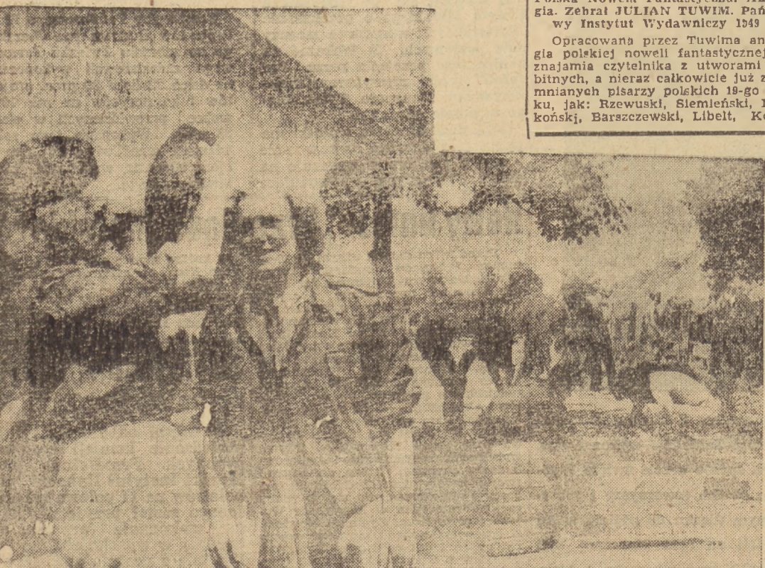
14 lipca rozpoczęła pracę przy odbudowie Warszawy międzynarodowa brygada młodzieżowa. Na pierwszym planie dziewczęta szwedzkie przymierzają mundur SP. Za nimi Czesi przy budowie nowego obrotu
