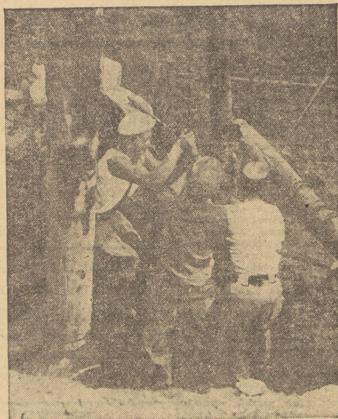
Budowa nowych gmachów w Gdańsku w pobliżu Motławy natrafia na wiele przeszkód. Przy ul. Długi Targ rozpoczęto budowę gmachu Centrali Handlowej Materiałów Budowlanych. Na torfiastym gruncie zakłada się ok. 100 pali żelbetonowych Strausa. Praca ta jest bardzo ciężka, ponieważ robi się wykopy, wybierając do głębokości 9 mtr. torf, glinę i piasek. Sama fundamentacja pali spowodowała na żwirze. Na zdjęciu robotnicy z Instytutu Wodnego Politechniki Gdańskiej przy wpuszczaniu konstrukcji żelaznej, do wkepanej w ziemię rury.
