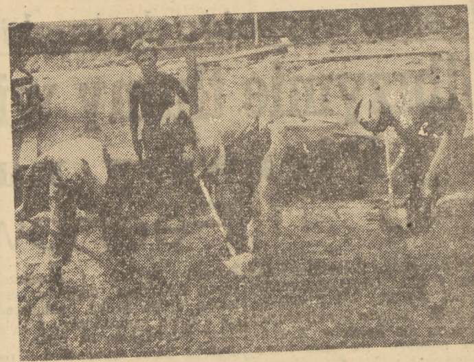
Junacy przy budowie arterii Gdańsk—Gdynia
