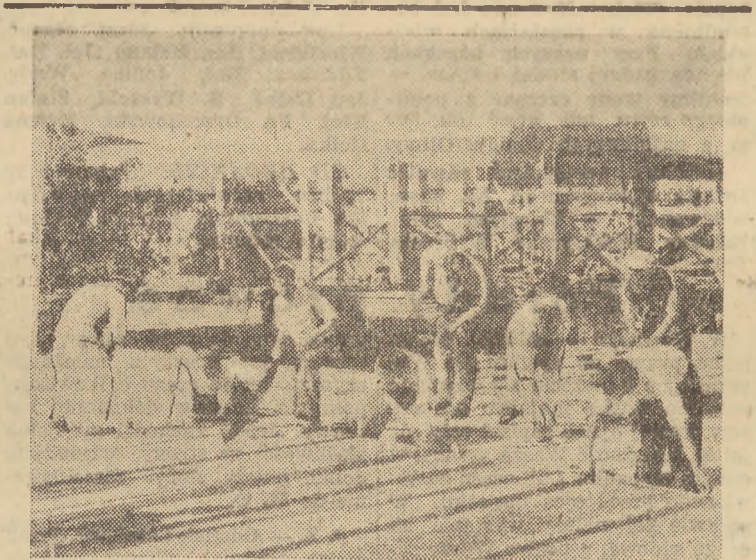
Robotnicy zajęci przy montowaniu szalowania stropu żelbetonowy-skrzynkowego w nowobudującym się gmachu Centrali Handlowej w Gdańsku w dniu wczorajszym ustanowili rekord prac ciesielskich. Pracują od lewej K. Szulc, St. Słoniński, Fr. Żugaj, J. Kasprzak, B. Rogala (senior), J. Rogala (junior), St. Jurczak, St. Pietrzak.
