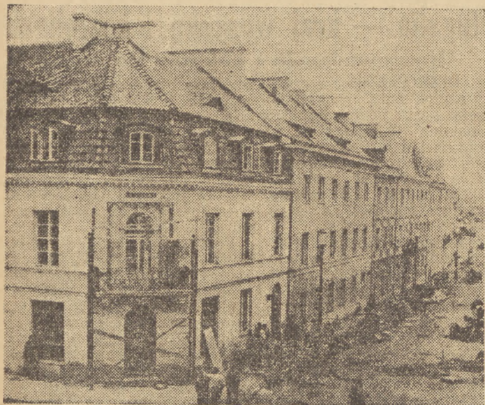
Nowowyprowadzona partia domów na Mariensztacie od strony ul. Bednarskiej w Warszawie
