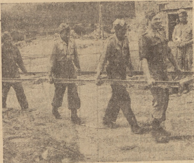
Młodzież SP rozpoczęła już III-ci turnus pracy. Na zdjęciu: junacy przy zakładaniu toru pod kolejkę do wywozu ziemi przy budowie autostrady Sopot—Gdynia
