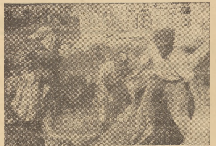
Robotnicy Państwowego Przedsiębiorstwa Budownictwa Przemysłowego Nr. 7, którzy rozpoczęli budowę magazynu Państwowego Zakładu Przemysłu Dzierżawskiego we Wrzeszczu, ul. Grunwaldzka 123, dokonali próby pobicia rekordu murarskiego Wybrzeża. Zespół składający się z ob. ob. Stanisława Nitki, Kazimierza Morawskiego i Józefa Dama, ułożył w dniu wczorajszym przy zakładaniu fundamentów 13.000 cegieł
