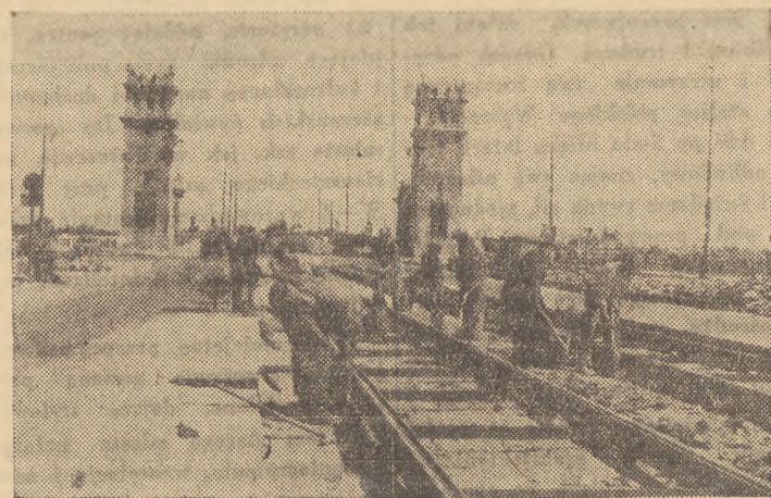
Na moście Poniatowskiego w Warszawie przystąpiono do wymiany nawierzchni. Praca według planu ma być zakończona w ciągu 3 tygodni. Ruch kołowy odbywa się normalnie
