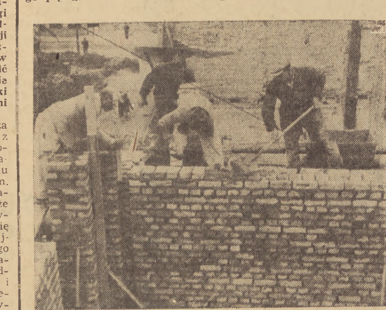
Rosną mury gdańskiego szybkościowca. Cały zespół pracuje z zapalem. Na zdjęciu murarz Stanisław Widesak i pomocnicy Stefan Gioska i Brunon Kędziora kładą cegły III piętra.
