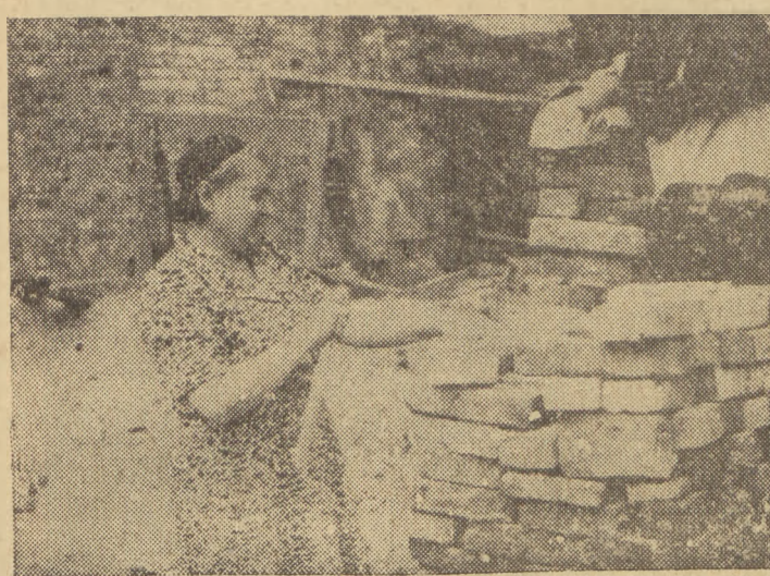
Wydobyte z gruzów cegły stanowią wartościowy materiał budowlany. Na zdjęciu: nauczycielka szkoły podstawowej Janina Kobiak układa wydobyte cegły
