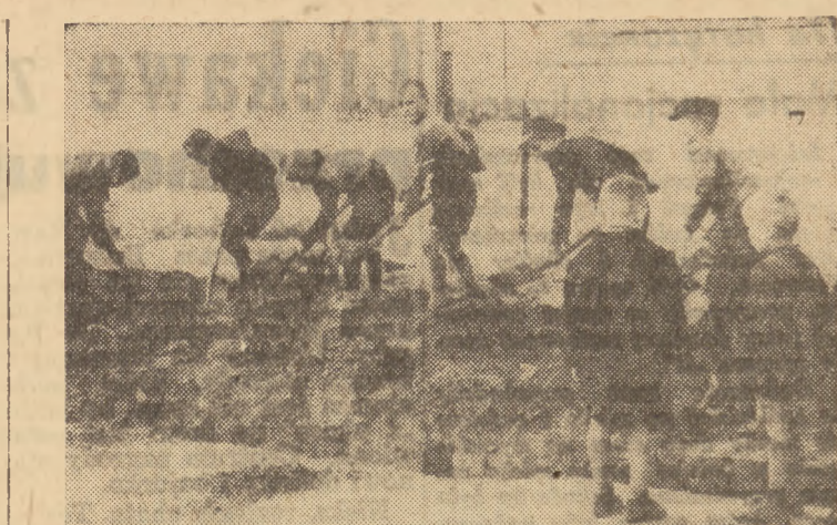
Młodzież szkolna Gdyni samorządnie wzięła się do pracy przy zasypywaniu rowu, wykopanego dla ułożenia kabla elektrycznego
