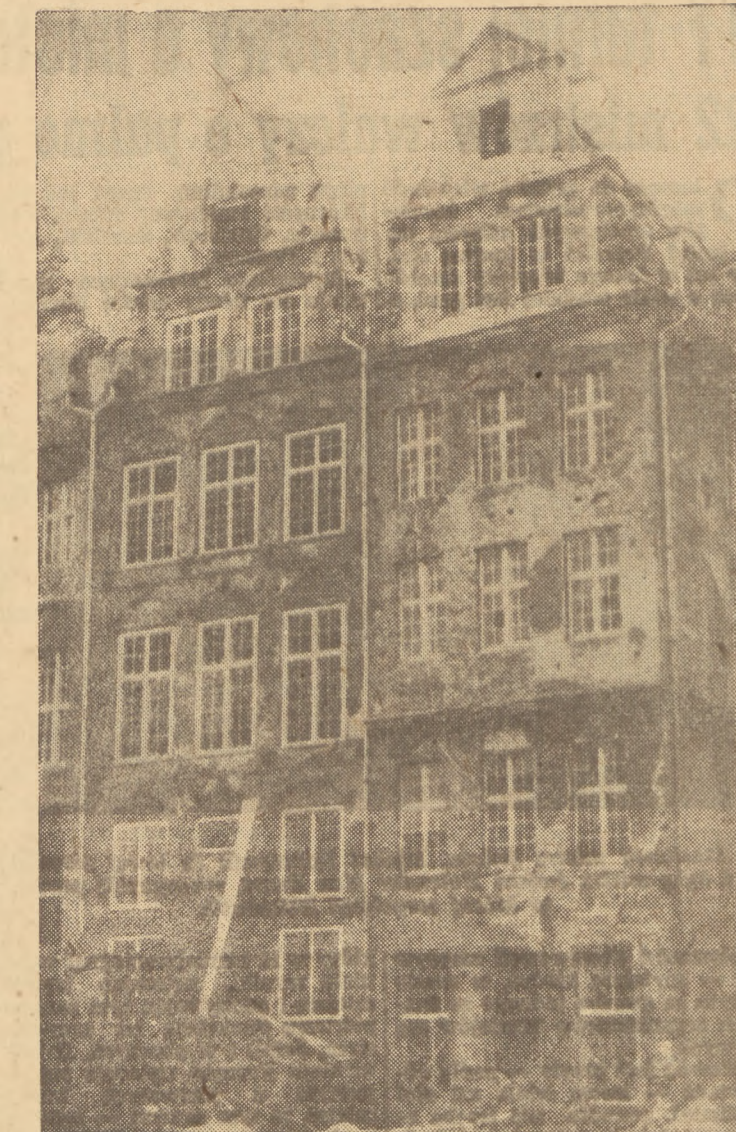
Na Starym Mieście w Gdańsku przy ul. Piwnej prowadzona jest odbudowa gmachów, przeznaczonych na siedzibę Gdańskiej Izby Rzemiosła. Kamienice utrzymane będą w starym stylu gdańskim
