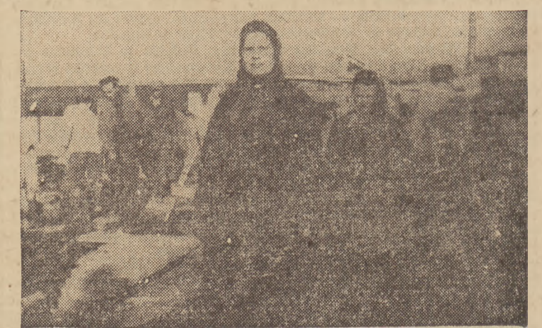
Przy budowie szybkościowca w Gdańsku - Wrzeszczu, wyróbiły się kobiety ob. Bielańska i ob. Polakowska. Na zdjęciu — robotnice dokonujące naprawy maszyn.
