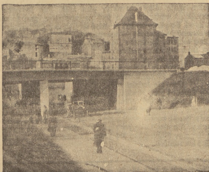
Nowowubudowany „Tuna Pakola” w Gdyni
