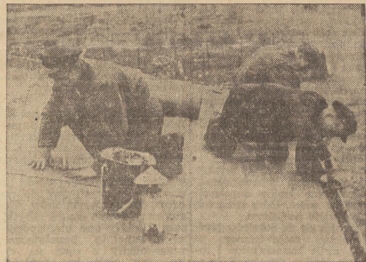
Praca przy reperacji własnego „dachu nad głową” idzie sprawnie. Chociaż ani Trinkl, ani Darol czy Kowzan nie są dekarzami — przybijają papę i smotując dach tak, jakby nigdy w życiu nic innego nie robili
