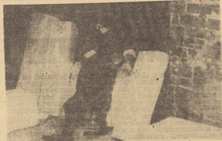
Gdańska Brama Wyżyną odżyła swoją dawną szale. Zniszczona podczas działań wojennych o złobne gzymsy, została wymalowana na nowo. We wnętrzu „Kamionki” kamieniarze ob. Jan Czuryldo i Gabriel Rochlicki wykuwają w płaskowcu ornamenty w postaci stylizowanych liści.
