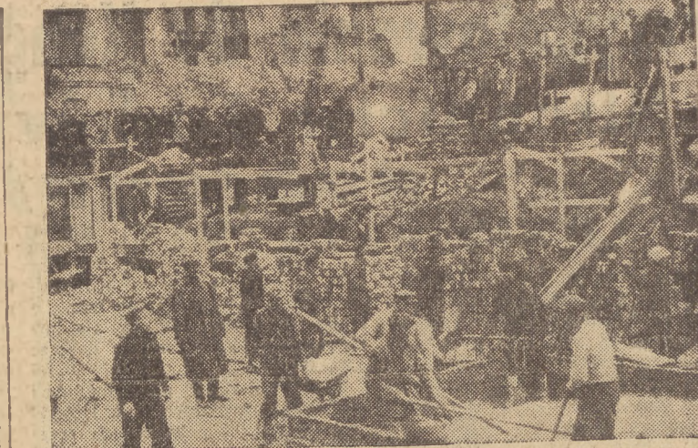
Robotnicy Betonstatu w Warszawie ustanowili nowy rekord Polski, wmurowując systemem potokowym 77 tysięcy cegieł w ciągu 8 godzin pracy, o czym donosił nasz w dniu wczorajszym. Na zdjęciu: ogólny widok budowy (dom Metalexportu); w głębi tłumy przyglądających się warszawiaków (Foto — AR)
