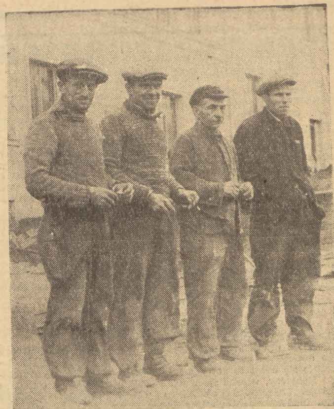
3 czterocobowe brgady cietelskie „Betonstalu” podjęły próbę ustanowienia nowego rekordu Polski. Każda brgda da wykonać podłogi i futryny w innym domu osiedla Mariensztackiego przy ul. Bednarskiej. Na zdjęciu — I brgda w składzie: J. Adamski, Fr. Rodak, St. Oleksiak i Szludur — wyrobiła do południa 919% normy godzinowej (wg. pobieżnego obliczenia). (Foto — AR)
