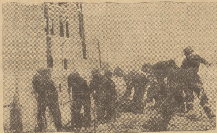
Odbudowę Starego Gdańsku przyspiesza udział całego społeczeństwa w akcji usuwania gruzów. Na zdjęciu — robotnicy Państwowych Przedsiębiorstw Budowlanych przy pracy.
