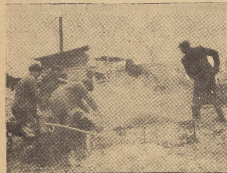
Mimo zimy na osiedlu muranowskim w Warszawie, wre praca. Na zdjęciu: lasowanie wapna przy użyciu gorącej wody. (Foto — AR)
