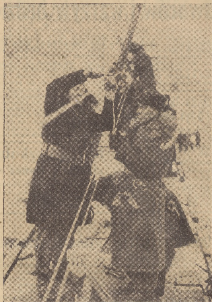
17 stycznia nastąpi otwarcie trzeciego z kolei zelektryfikowanego odcinka węzła warszawskiego Warszawa — Żyrardów. Na zdjęciu: Montowanie przewodów elektrycznych. (Foto — AR)
