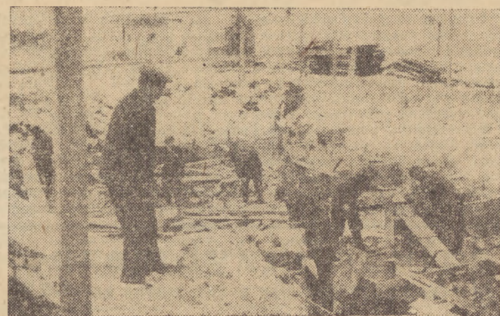
Cieśle przy pracy w wykopie pod nowe budynki na osiedlu muranowskim w Warszawie.
