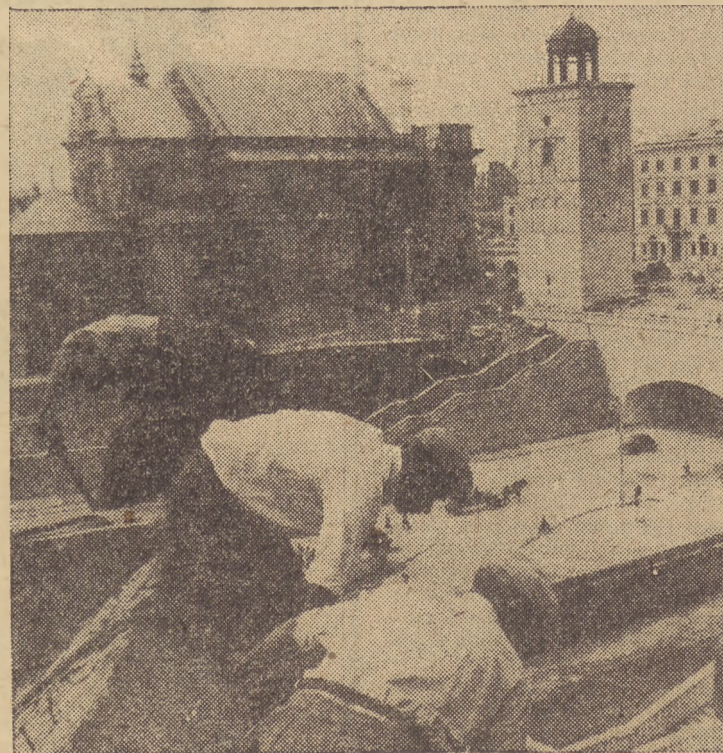
Trasa W—Z w trakcie budowy. W głębi Kościół Sw. Anny z zabytkową dzwonnica.
