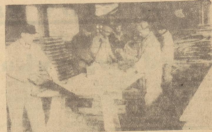
Pracę mroźców Państwowe Przedsiębiorstwo Budowlane Nr 2 kontynuację roboty. Na zdjęciu widzimy cięśli, pracujących przy budowie PDT w Gdyni.
