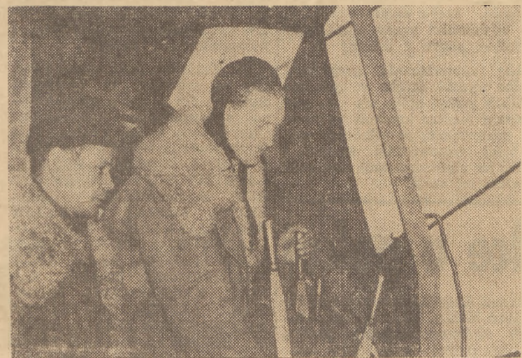
Maszynista koparki chwyłkowej Centrali Sprzętu Budownictwa — Oddział Warszawski Tadeusz Ofiarski i jego pomocnik Henryk Osiak, podejmując apel tow. Markiewki, zobowiązali się przepracować 5815 godzin bez remontu kapitalnego koparki przy jednoczesnym podniesieniu wydajności pracy do 150 procent. Tow. tow. Ofiarski i Osiak wezwali jednocześnie innych maszynistów do podjęcia tej formy współzawodnictwa.
