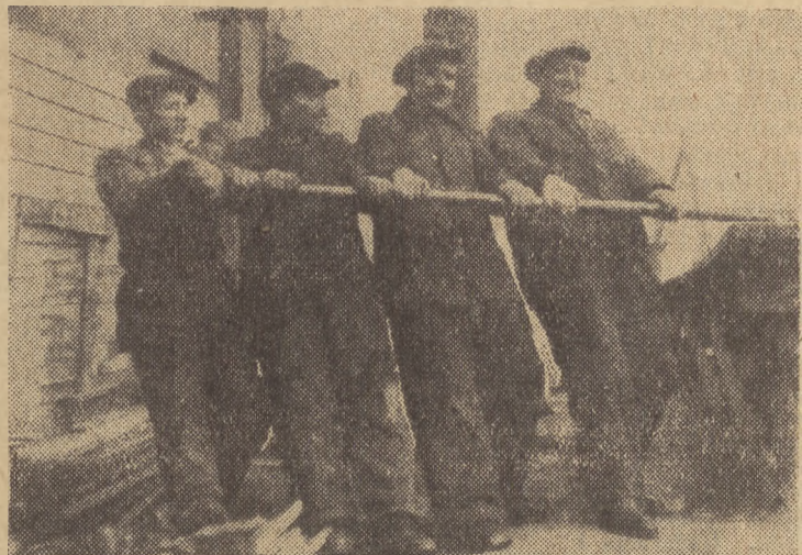
Zespół zbrojny pracujący przy budowie tunelu linii średnicowej w Warszawie wykonując średnio w okresie od 1.XI.1949 r. do 1.I.50 r. — 690 procent normy. Od narady produkcyjnej, którą odbył się 10.II.50 r. zespół podwyższył wyniki pracy i obecnie wyrabia 965 procent.
