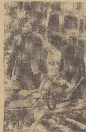
Bardzo ważną rolę w murarstwie odgrywają pomocnicy, którzy dozwolają murarzom cegły oraz zaprawę. Na zdjęciu widzimy pomocników murarskich, dokonujących na tarczach cegieł do budowy przy ul. Długiej. (Foto — W. Cella)
