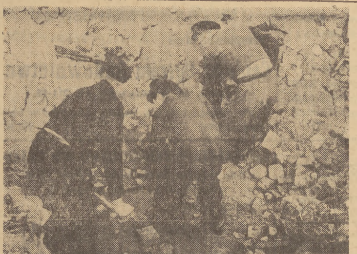
Rozbiórka i wywożenie gruzów odbywa się bardzo energicznie. Na zdjęciu robotnicy PPB Nr 4 pracujący z wielkim zapalem przy oczyszczaniu terenu. (Foto W. Celis)
