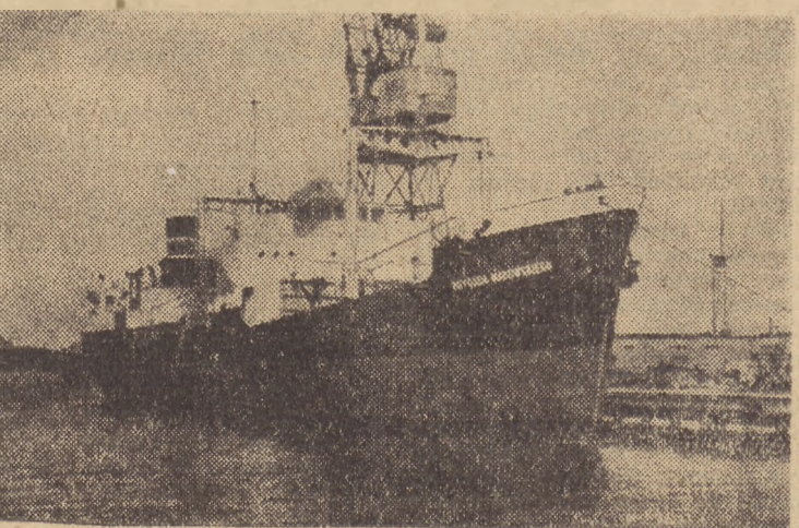
Na rudowęglowcu s/s „Brygada Makowskiego” trwa gorączkowa praca. Stocznicy i marynarze przygotowują nową jednostkę do próbnego rejsu. (Foto — A. Kwiatkowski)
