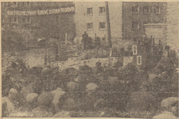
Dnia 23 bm. rozpoczęto na Muranowie C w Warszawie pierwszą budowę bloków mieszkalnych systemem potokowym. Przed rozpoczęciem pracy w obecności przedstawicieli partii, zw. zawodowych oraz robotników zatrudnionych na budowie umurowano akt erekcyjny. Robotnicy przystępujący do budowy podpisali zobowiązania i otrzymali szczegółowe harmonogramy pracy.
