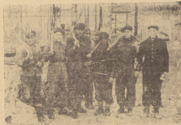
Pracująca brгада Barańskiego z PPB Nr 4 pracuje przy odbudowie ulicy Ogarniej i Długiej. Brгада ta w ostatnim czasie współpracownictwa osiągnęła wysokie wyniki. (do art. obok) (Foto W. Cella)
