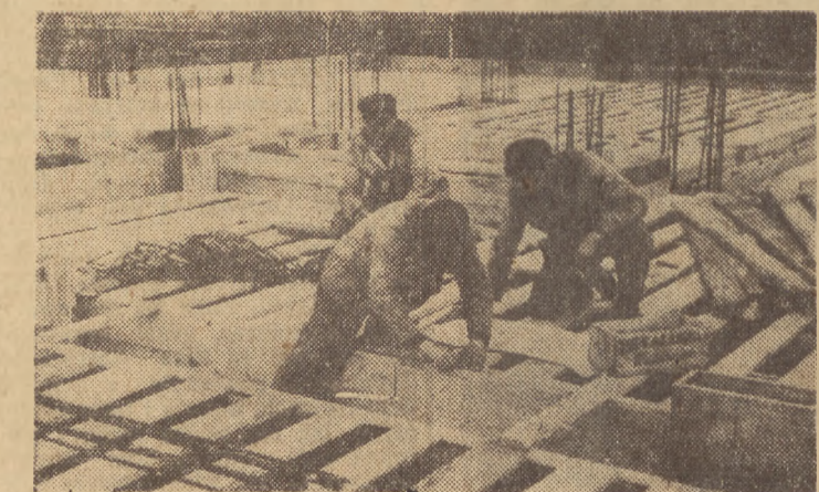
Grupa zbrojarczy zatrudnionych przy budowie PDT we Wrzeszczu. Na zdjęciu: robotnicy Keczniowski, Miecznikowski i Romejko, którzy wyrobilią przeciętnie po 247% normy.
