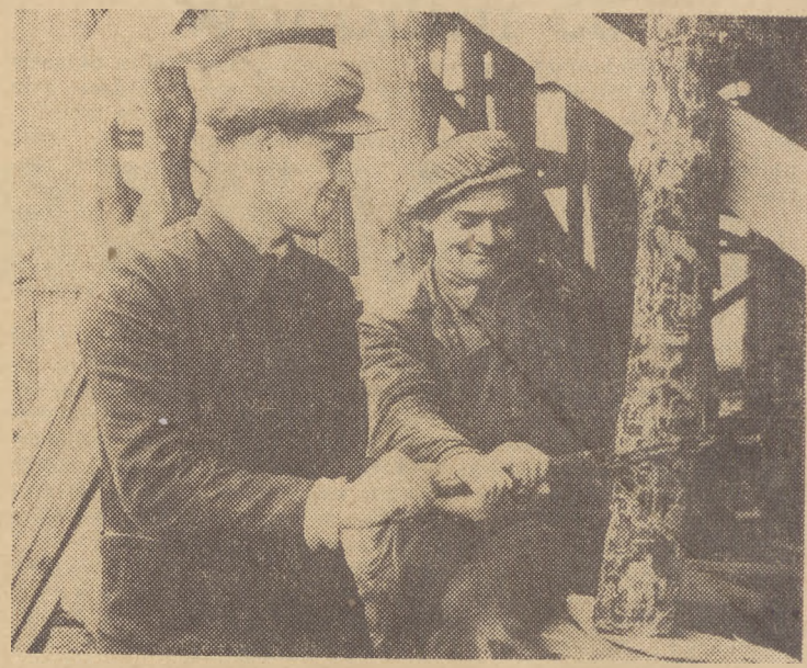
Dwaj racjonalizatorzy tow. tow. Kinder Leon i Zielke Franciszek przy budowie nowego gmachu Straży Pożarnej. (Do artykułu obok)
