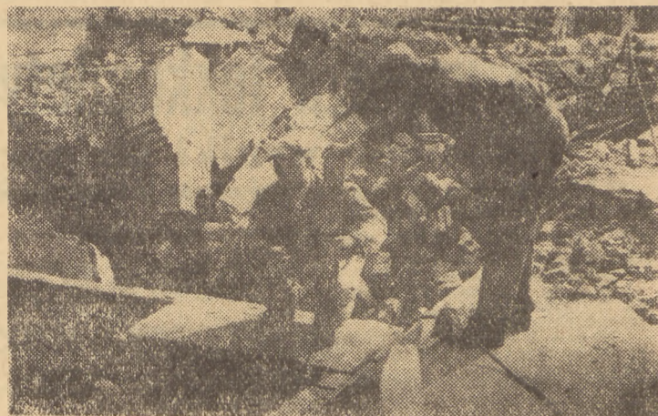
Robotnicy Państwowego Przedsiębiorstwa Budowlanego Nr 2 sprawdzają poziom fundamentów przy jednej z budowli na ul. Długiej.
