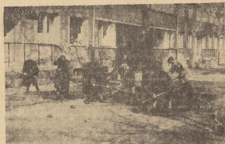
W dzielnicy robotniczej, przy ul. Kosciuszki, prowadzone są prace przy urządzaniu trawników
