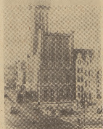
Rok 1948 — rekonstrukcja murów zewnętrznych.
