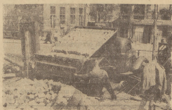
Mechanizacja pracy w budownictwie postępuje w szybkim tempie naprzód. Na zdjęciu — radziecki samochód ciężarowy — wyrotnica marki „Zis” przy pracach na ul. Piłsudskiego w Gdańsku.
