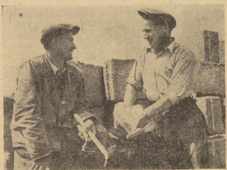
Józef Piaszyński, murarz — przodownik pracy, wraz z pomocnikiem, Stanisławem Gugałą, osiągnął w dniu 16 bm. 226,9 procent nowej normy. Piaszyński pracuje w Przedsiębiorstwie Budownictwa Przemysłowego w Warszawie. (Foto-Alt)
