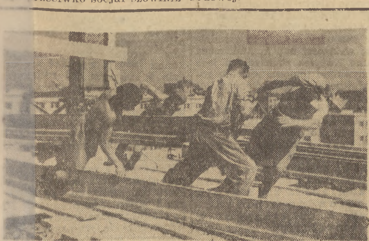
Brigada młodzieżowa betoniarzy Skarżyskiego pracująca przy budowie bloku nr 143 na Muranowie. „C” w Warszawie osiąga ok. 180 procent nowej normy.
