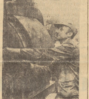
Ob. Zawsawski obsługuje betoniarke
